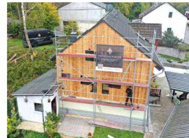
So sieht ein Holzbau à la Zimmerei Fuchs aus.
