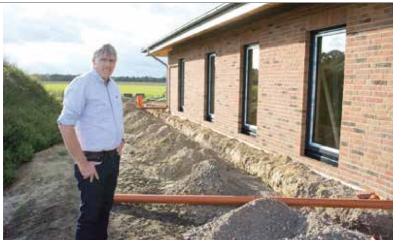
Ulrich Birkemeyer steht an einem erst kürzlich an den Kunden übergebenen Holzrahmenhaus mit Klinkerfassade. Jedoch nicht schlüsselfertig wie sonst, denn der Besitzer ist ein Handwerkskollege, der selbst noch Hand anlegen will.
