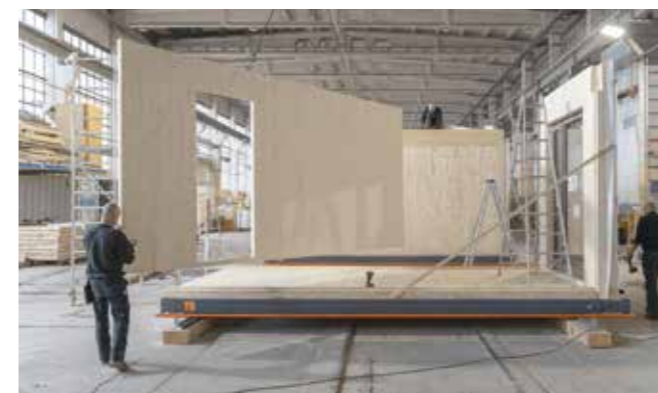
Vorfertigung der Büromodule (oben) und Zusammenspiel von Holz und Beton im Erdgeschoss.
