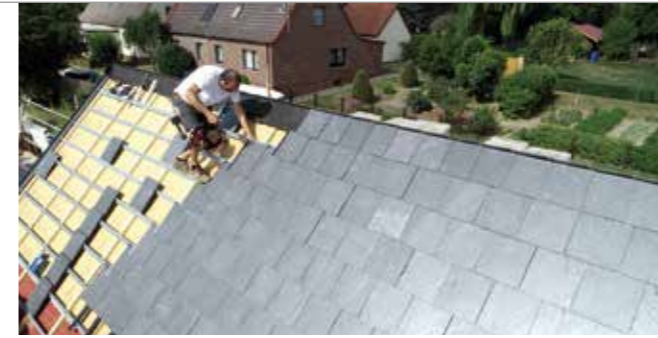
Die Dachflächen wurden mit 40 x 40 Zentimeter großen Schiefersteinen der Rathscheck-Marke InterSIN entsprechend der gewählten Rechteck-Doppeldeckung im halben Verband angeordnet.
