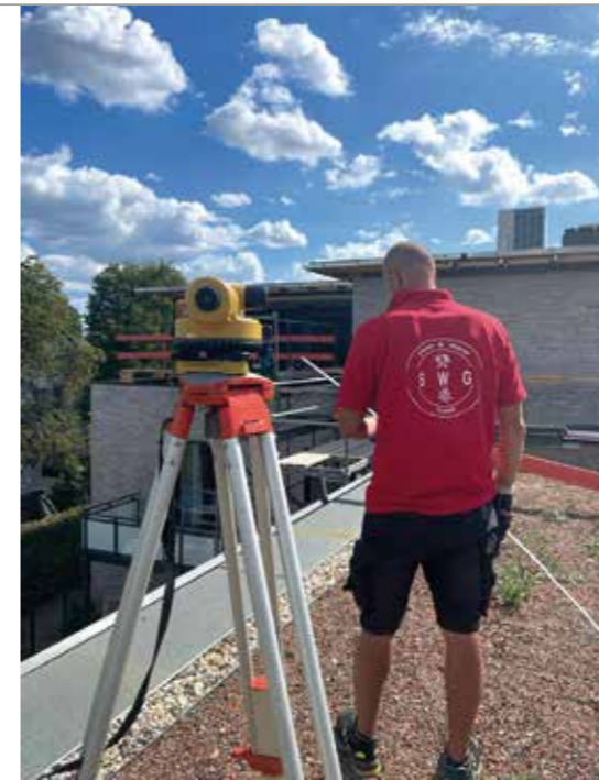
Vermessung auf dem begrünten Flachdach
