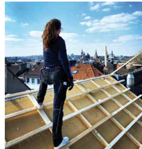
links: Niél Braun würde auch als Chefin gerne öfter selbst auf dem Dach arbeiten.
