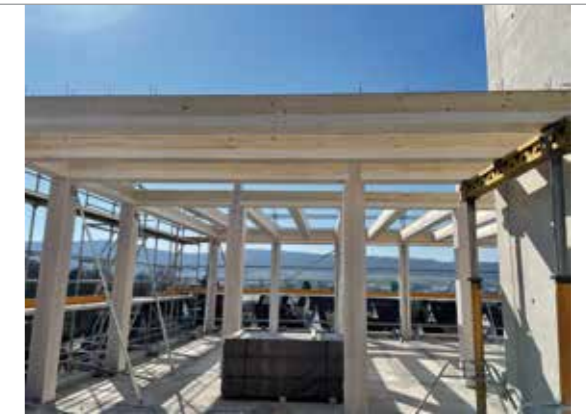
Neubau eines mehrgeschossigen Bürogebäudes für den Wald-campus der Hochschule in Aalen: Holzskelettbauweise mit Betonfertigteilelementen und vorgehängten Holzrahmenbauwänden.
