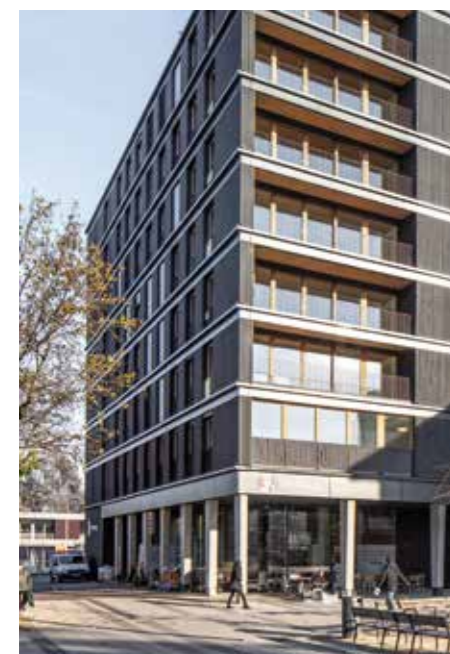
links: Erbaut in Holztafelbauweise: Das Gebäude Buggi 25.
