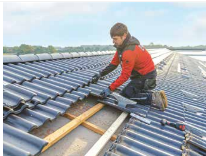
Die Solar-Trägerpfannen von FLECK lassen sich perfekt in bestehende Steildächer integrieren.
