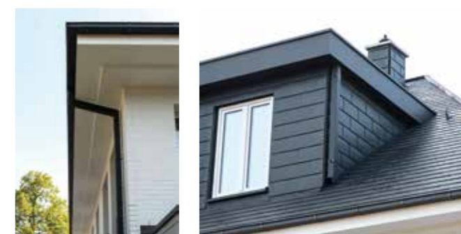
Bei der Dachentwässerung entschied man sich für eine sechsteilige Kastenrinne, die sogenannte Hauskrawatte von haushaut.
