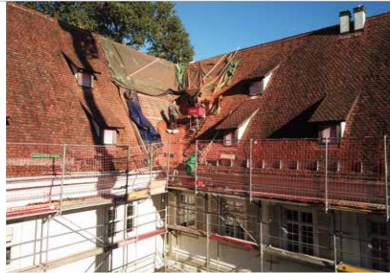
Die Dachdecker hatten es mit 13 Metern eingebundener Kehle zu tun.
