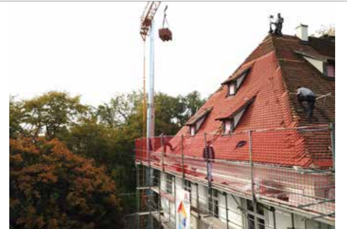
Das Dach wurde in Abschnitten abgedeckt und dann neu gemacht.
