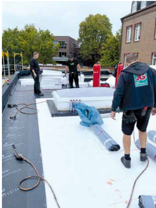
Flachdacharbeiten auf einem Gewerbeobjekt inklusive Lichtkuppeln.
