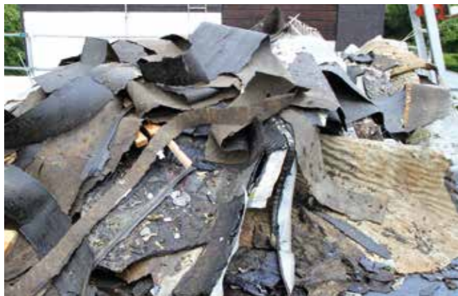
Die Reste der abgerissenen Kunststofffolie und Holzlatten gesammelt für den Müllcontainer.
