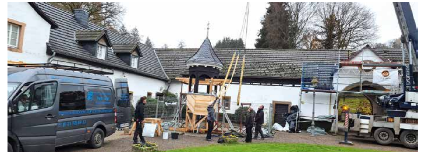
Da ist die Arbeit am Holzturm fast vollendet. Mithilfe des Krans wird er wieder neu an seinen alten Standort transportiert.
