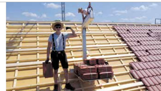
Lehrling Marcel Benecke hat Spaß bei der Arbeit, die Materialien kommen per Kran aufs Dach.
