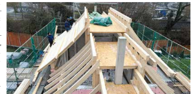
Hier sind die Podeste zu sehen, die komplett vom Kran aufs Dach gezogen wurden.
