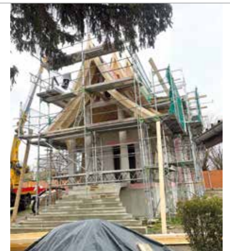
Vier verschiedene Dachstühle hat dieses eher kleine Tempelgebäude.
