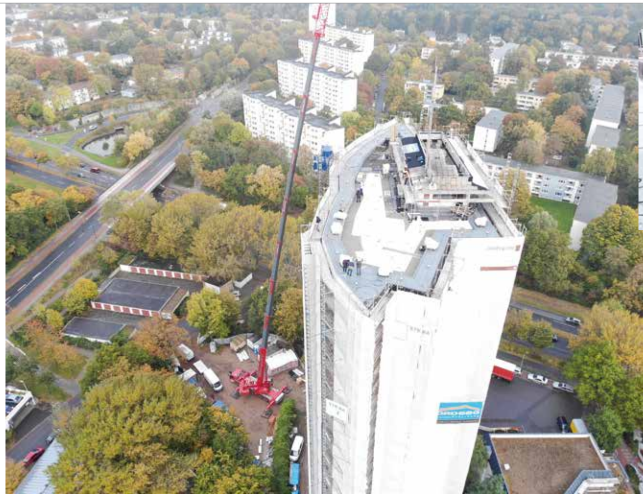
Vorzeigeobjekt: Flachdachsanieierung auf dem Aalto-Hochhaus in Bremen-Vahr.
