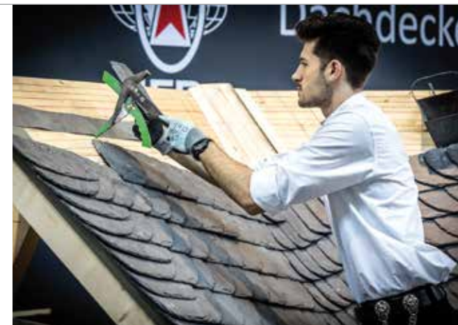
Noah Zimmer passt eine Schieferplatte für die Eindeckung an.
