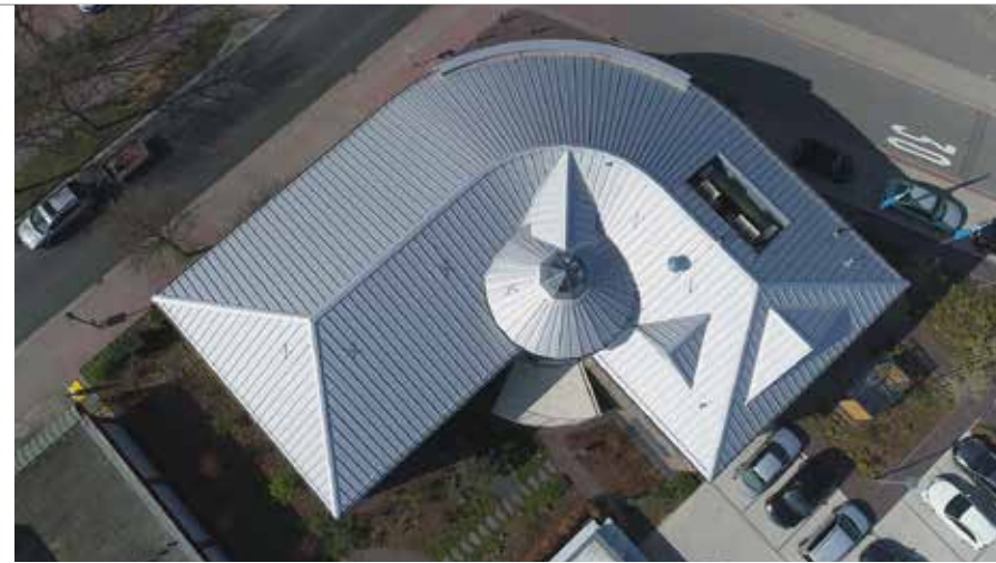
Metалldächer von Kalzip sind eine Spezialität von Dadego.
