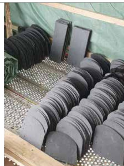
Das Material für die Schiefereindeckung liegt bereit.
