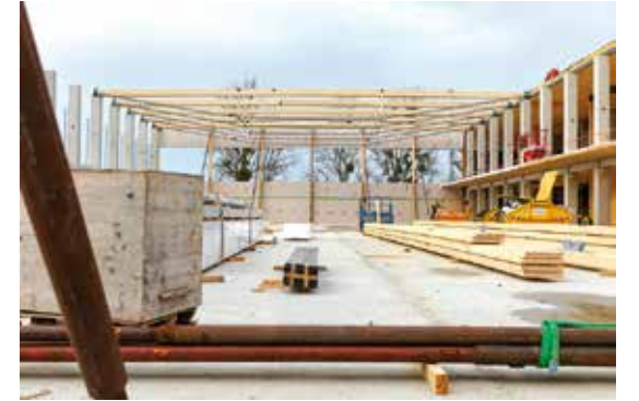
Eine Binderkonstruktion aus Holz bildet das Hallendach.
