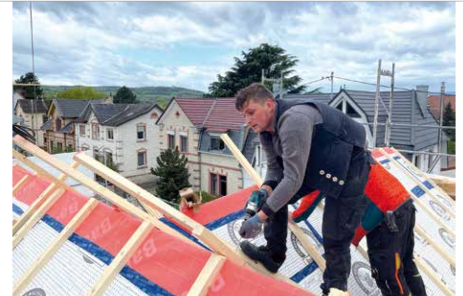
Mitarbeiter bei der energetischen Steildachsanieurung.
