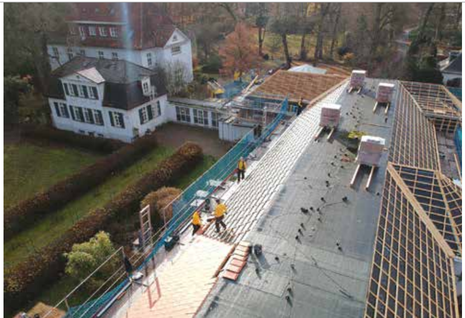
Der Betrieb ist ein klassischer Allrounder – hier zu sehen eine größere Steildachsanierung.
