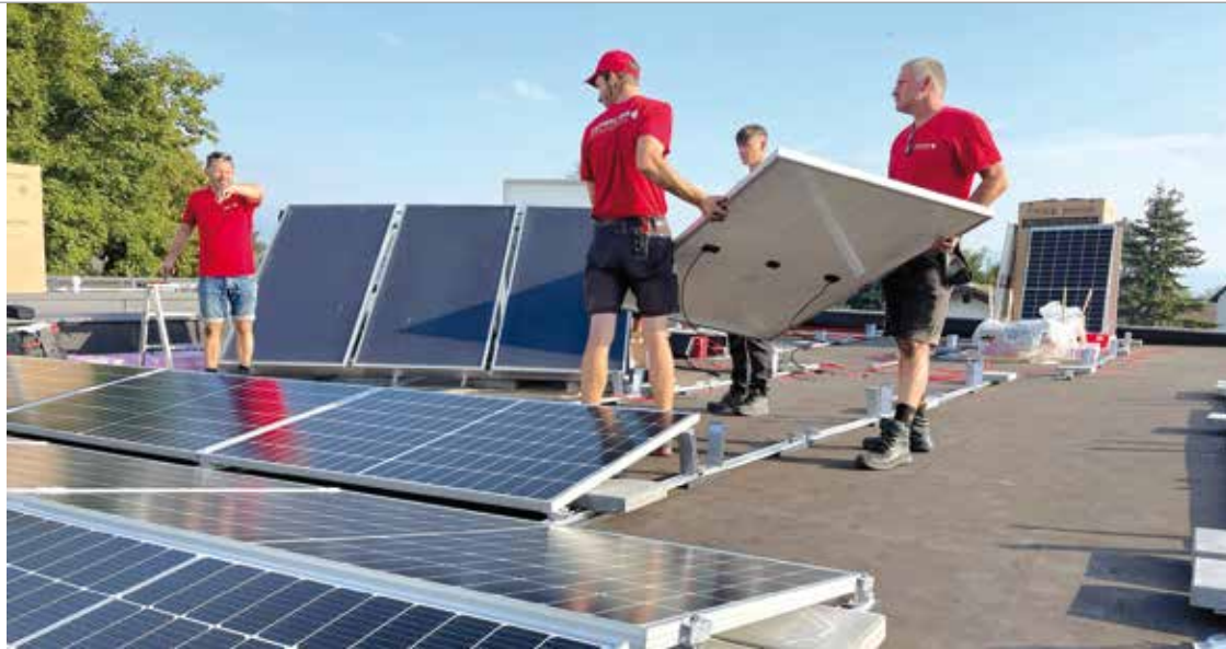
Michael Zimmermann (links) bei der Montage einer PV-Anlage auf dem Flachdach.
