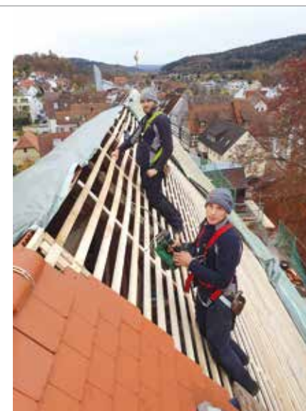
Dachdeckergeselle Daniel (hinten) und Azubi Alfredo decken die Stadtkirche Lorch ein.
