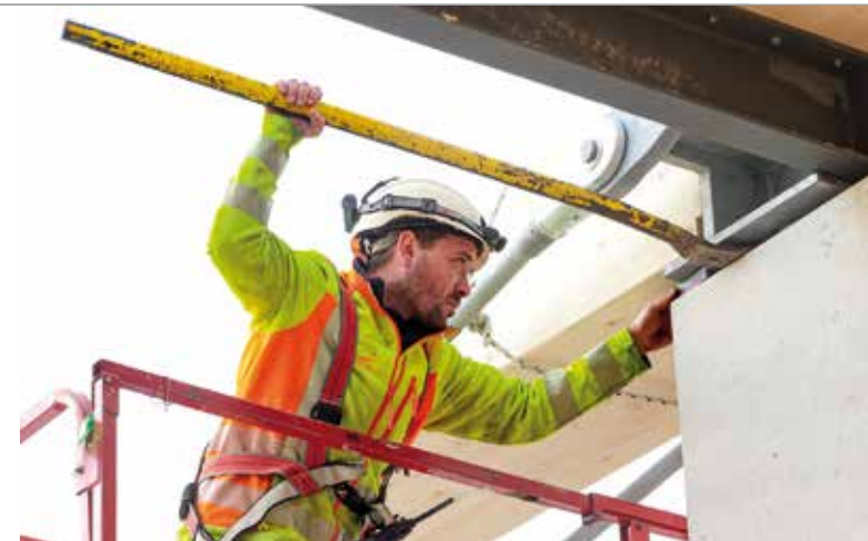
Die tonnenschweren Dachelemente werden in Position gebracht.
