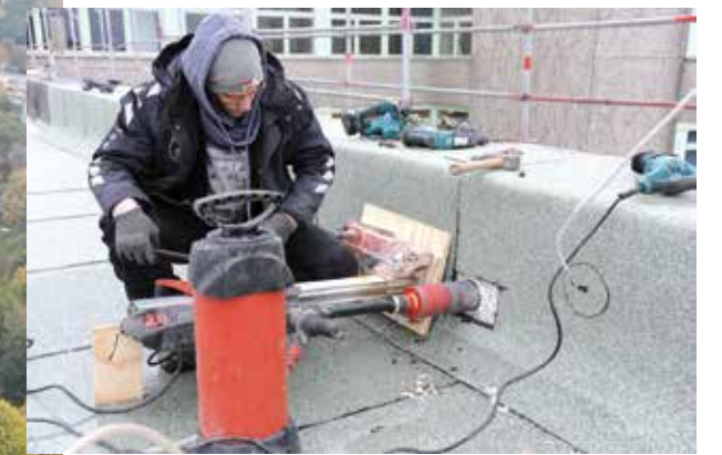
Bohrung durch die Außenwand auf dem Flachdach der Oberschule Lerchenstraße in Bremen-Nord.
